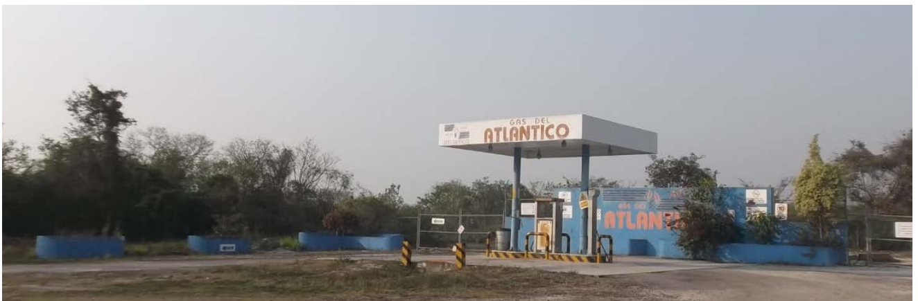
Estación de Carburación Rinconada
