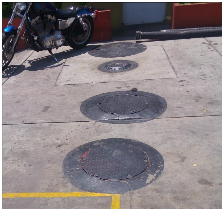
Fotografía 6. Zona de tanques de almacenamiento de Diesel.
