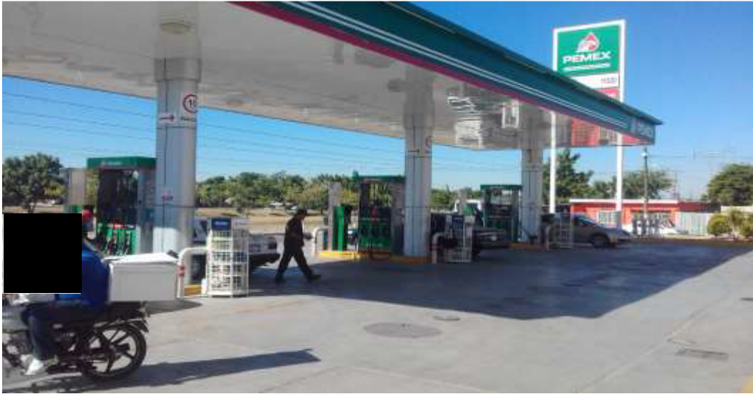
Fotografía 1. Vista general de la ES. 11620 y zona de tanques de almacenamiento.
