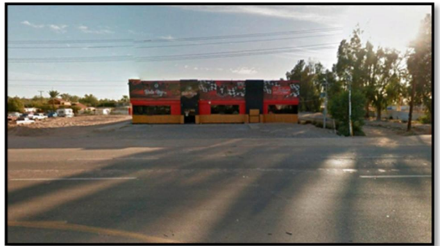
Vista norte - sur
