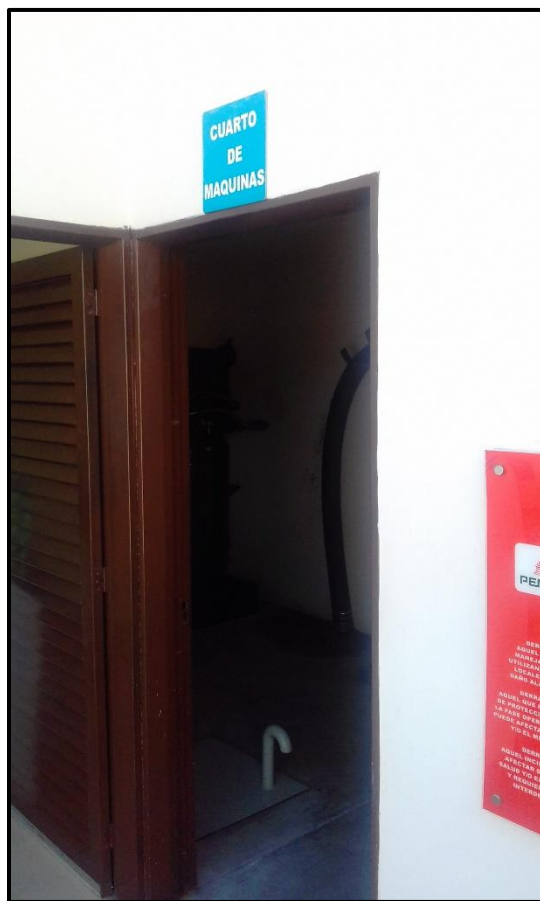
Fotografía 3. Acceso al cuarto de máquinas.
