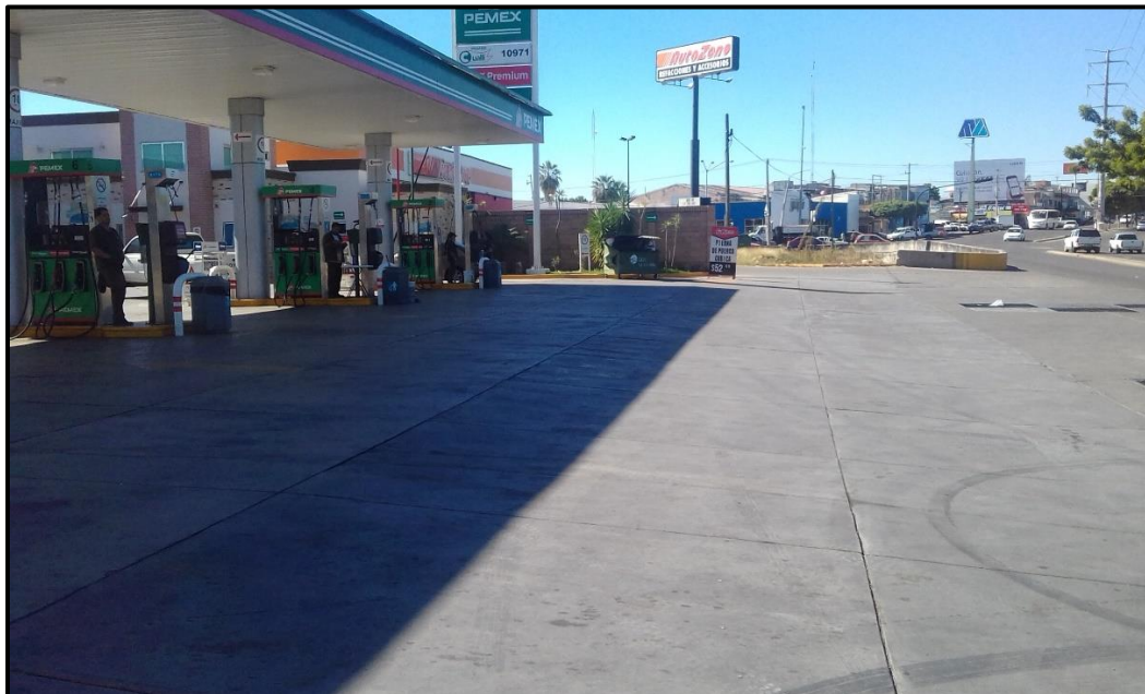
Fotografía 1. Vista general de la zona frontal de la Estación de Servicio.
