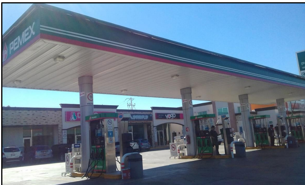
Fotografía 4. Vista general de la zona de despacho.
