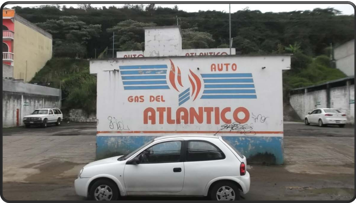
OESTE: Estación de Carburación colindante con predio sin uso (29.64 m)
