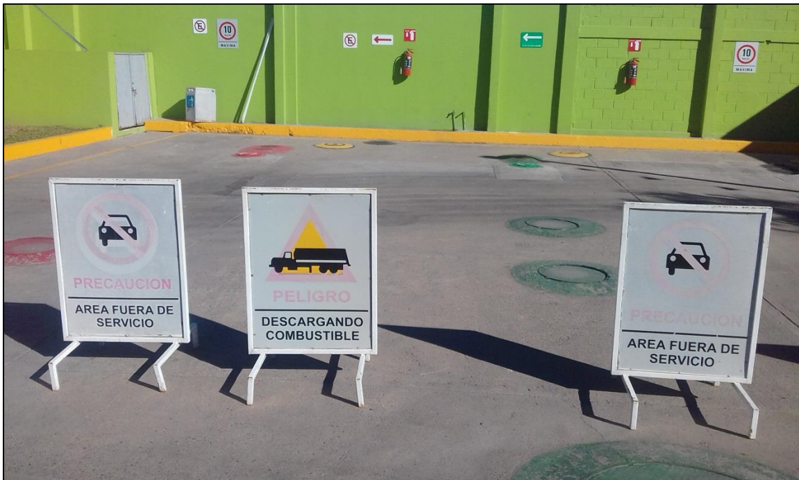
Fotografía 5. Área de tanques de almacenamiento.
