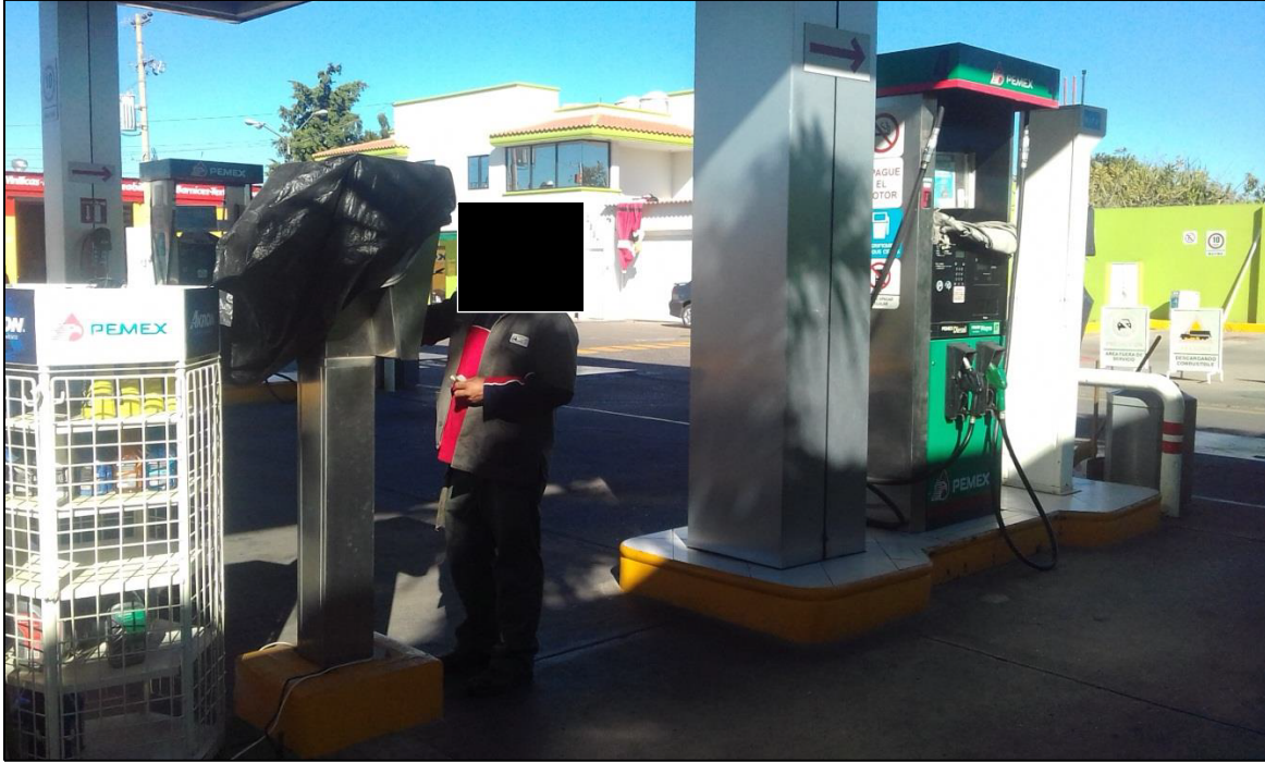
Fotografía 4. Modulo doble de gasolina y diesel.
