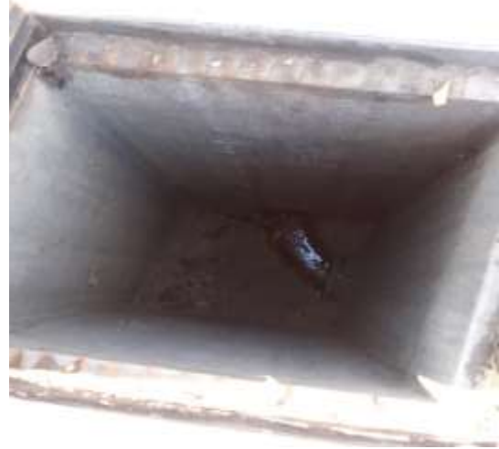
Figura 28. Observación de rampas para evitar el derrame de sustancias consideradas como peligrosas, y de esta manera son recuperadas y manejadas de la manera más adecuada según la normativa.
