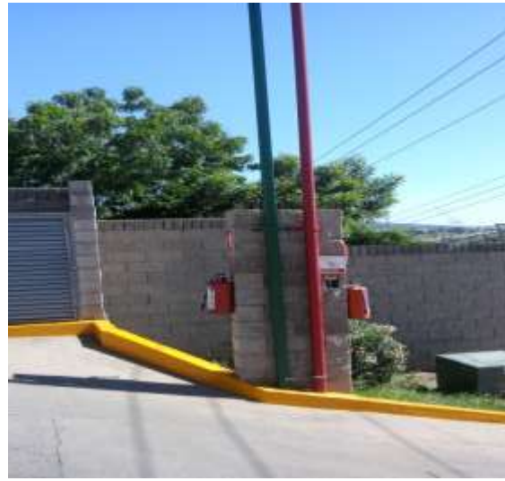
Figura 20. Observación de extintores de acuerdo al cumplimiento a los lineamientos de seguridad y prevención social.
