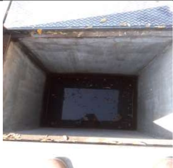
Figura 26. Las aguas oleosas son canalizadas hacia una cisterna para su almacenamiento y para ser recolectada por empresas especializadas para su tratamiento y que cuenten con el permiso correspondiente. Se anexa comprobante de servicios de empresa autorizada.
