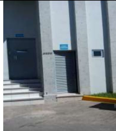
Figura 14. Observaciones del área de control eléctrico de la estación de servicio.
