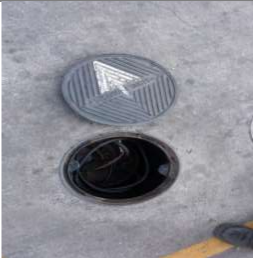
Figura 25. Evidencia fotográfica de la instalación de sistema de tierras físicas.
