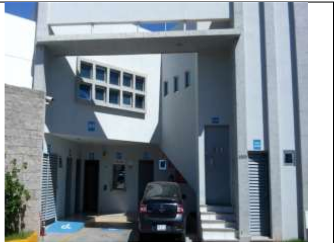
Figura 10. Observación de oficinas en planta alta, baños, área de estacionamiento, adecuaciones para discapacitados, cuarto de máquinas, área de sucios, caja.
