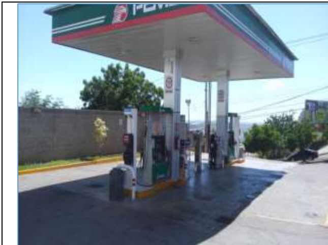
Figura 9. Área de despachadores de gasolina.
