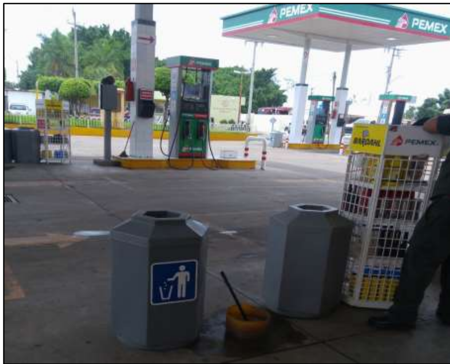
Fotografía 10.- Vista de los Módulo de despacho.
