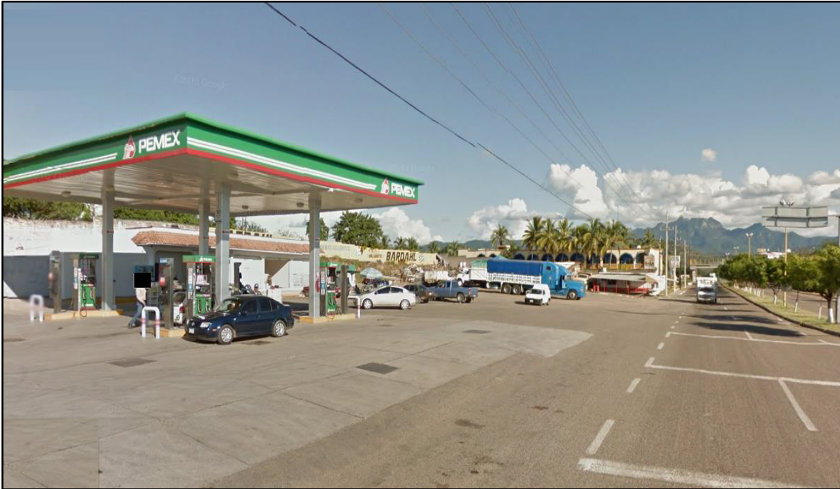
Fotografía 3.- Vista de la estación hacia el sureste y salida a Tepic
