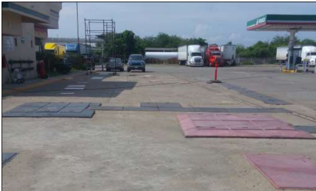
Fotografía 6. Zona de Tanques de Almacenamiento.
