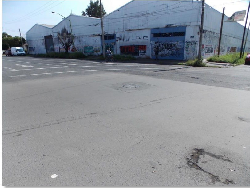
Figura 17. Registro de drenaje enfrente del predio.
