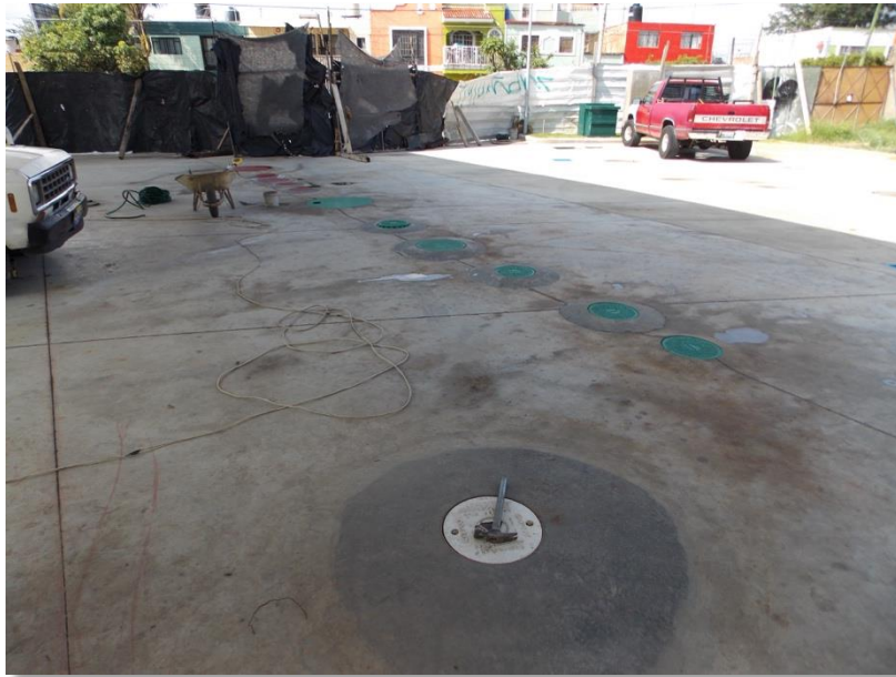
Figura 19. Imagen del área de tanques de la gasolinera.
