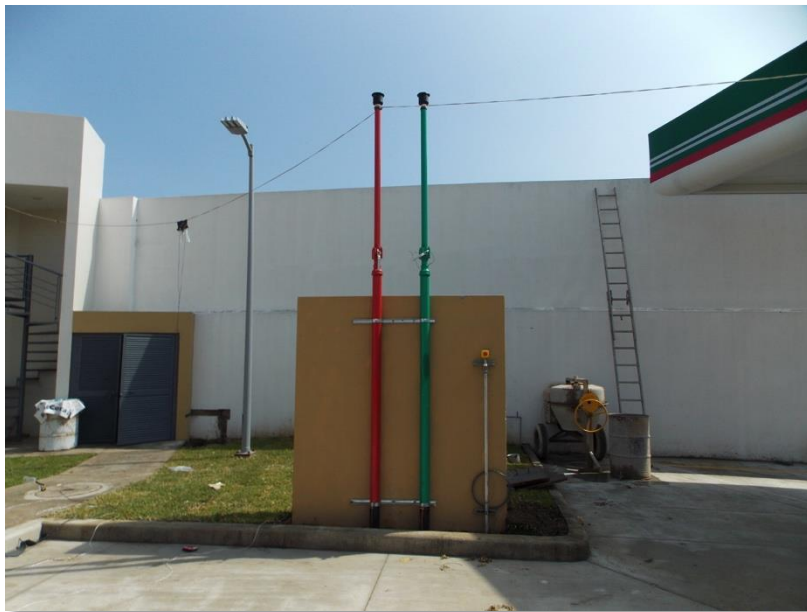
Figura 14. Imagen de los tubos de venteo instalados en la E.S.
