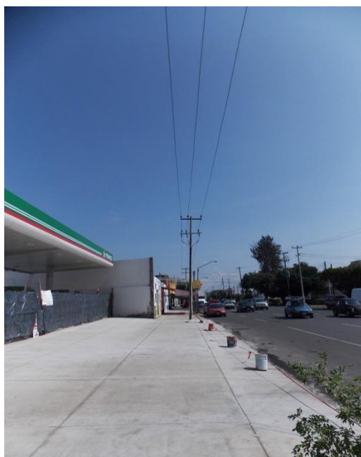
Figura 16. Línea eléctrica que colinda con el proyecto.
