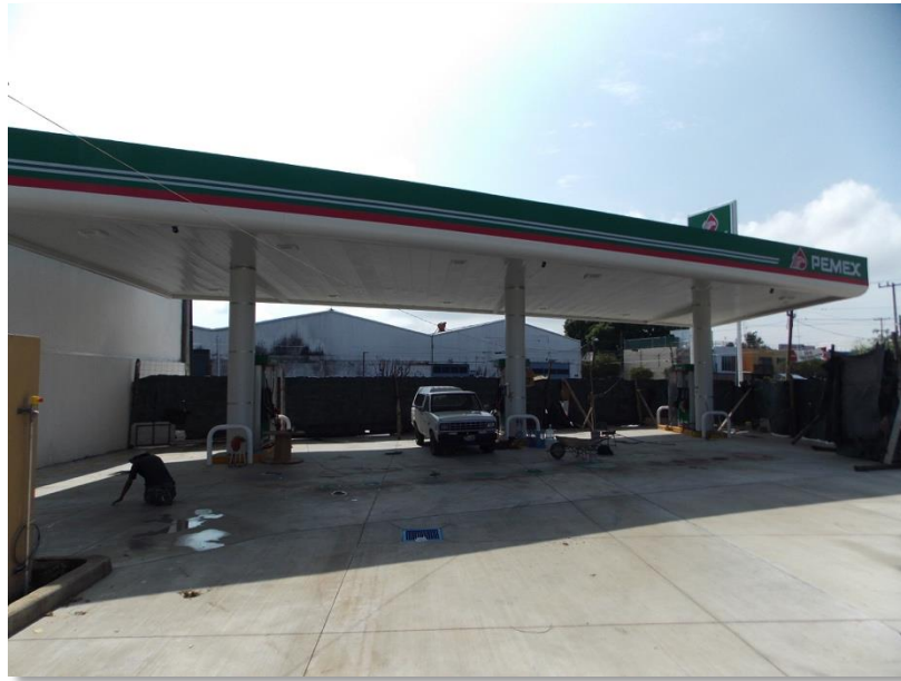
Figura 11. Imagen del área de despacho de la gasolinera.
