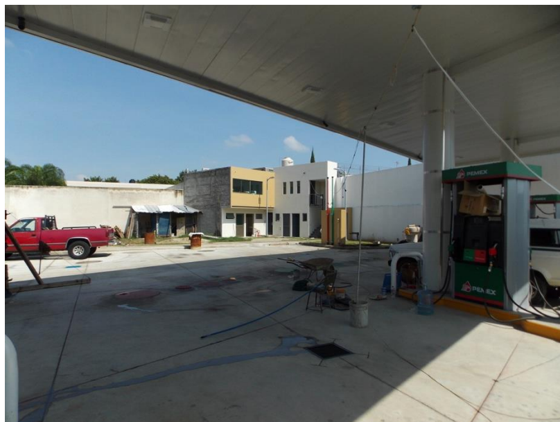
Figura 1. Imágenes del grado de avance de la obra (septiembre 2016).
