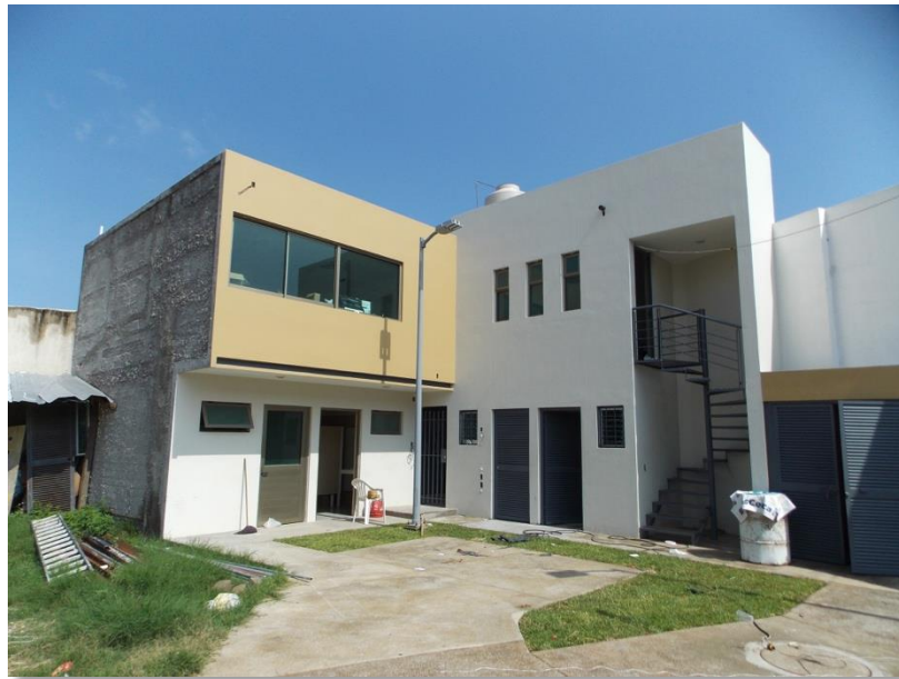
Figura 10. Imagen del avance de la obra civil de las oficinas.
