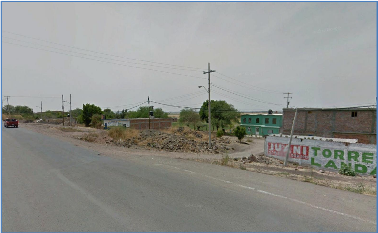
Foto III.1.a)-3. Vista desde la Carretera Estatal Irapuato-San Cristóbal, hacia las fincas ubicadas al frente del predio, colindancia Este.
