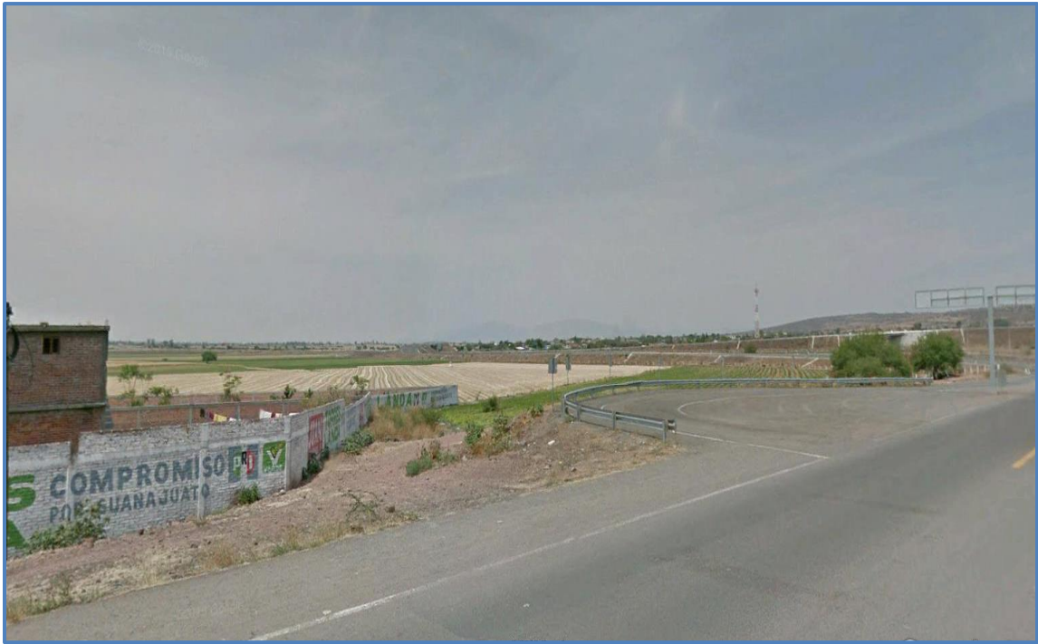
Vista desde la Carretera Estatal Irapuato – San Cristóbal, hacia la colindancia Oeste, en donde se aprecia el fondo el paso del Libramiento Poniente de Irapuato. .
