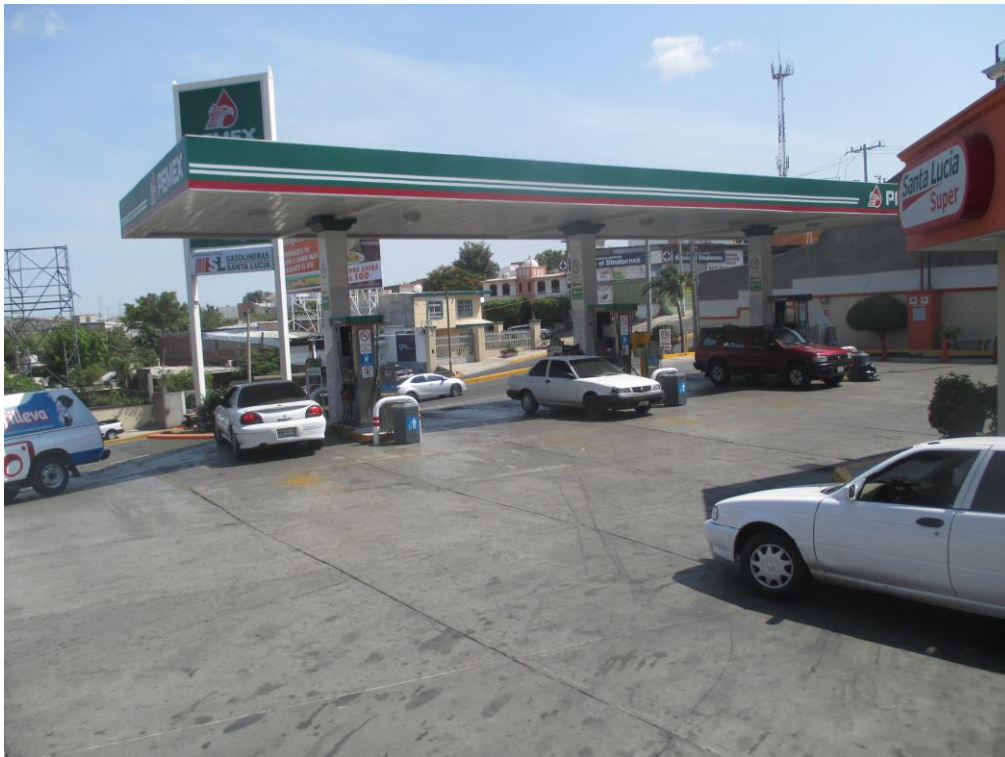
Memoria fotográfica de la estación de servicios
