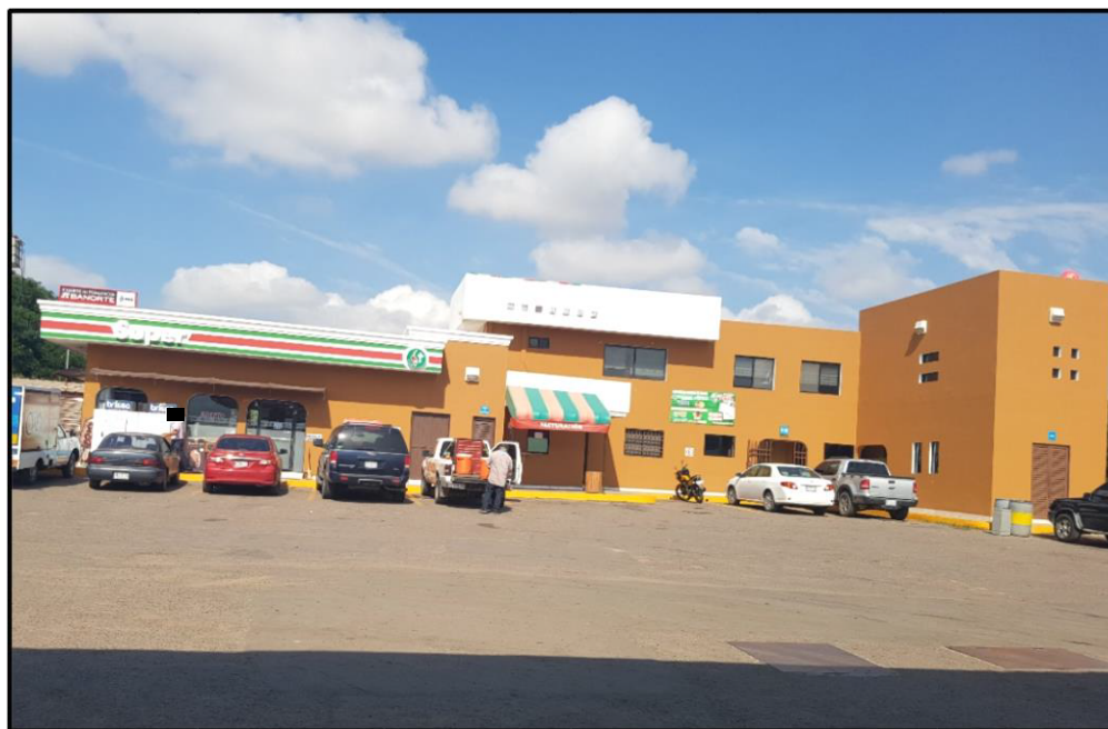
Fotografía 4. Vista General de Tienda de conveniencia y área administrativa.
