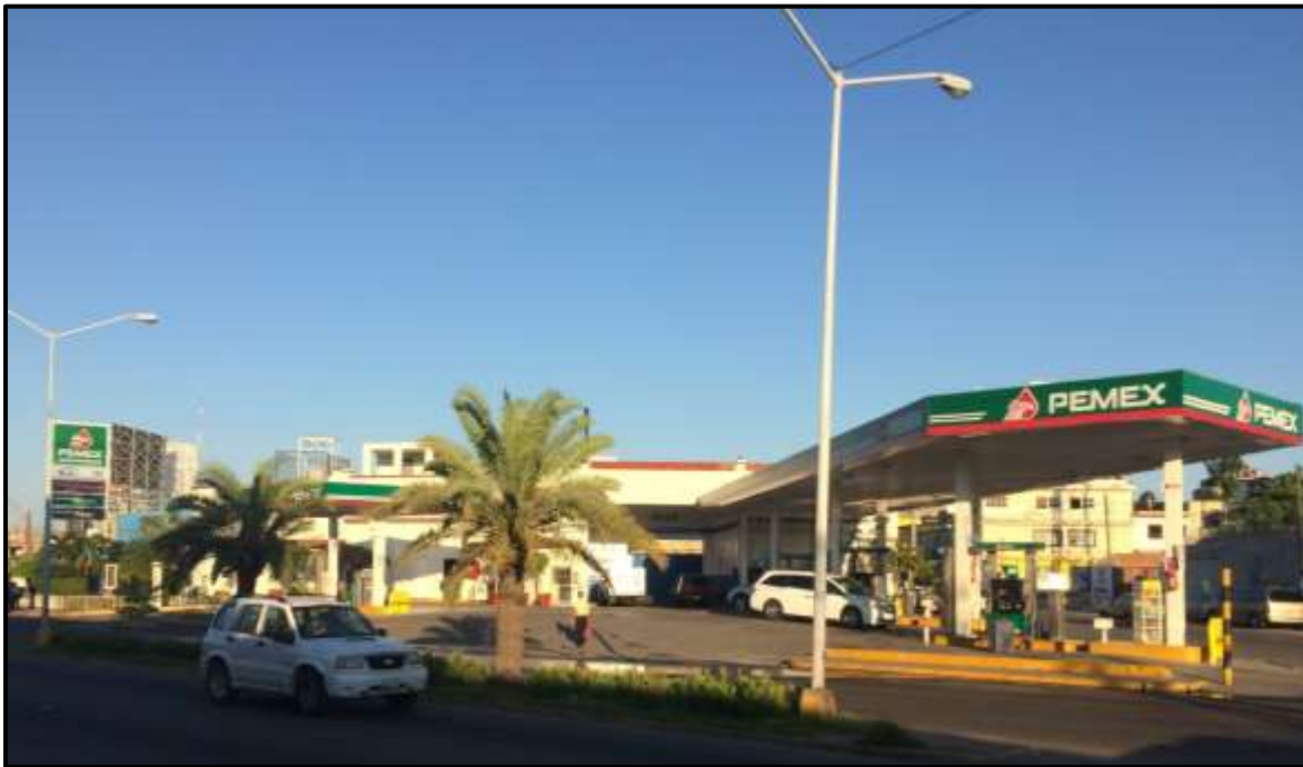
Fotografía 1. Vista general de la Estación de Servicio
