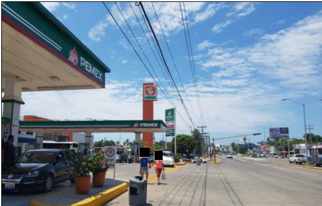
Fotografía 10. Vista de la Estación de Servicio por la Av. Rafael Buelna.
