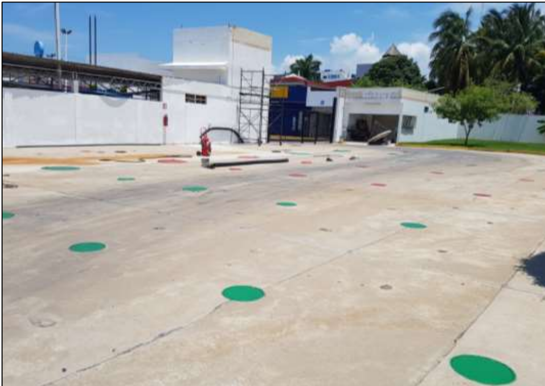
Fotografía 8. Zona de Tanques de Almacenamiento.
