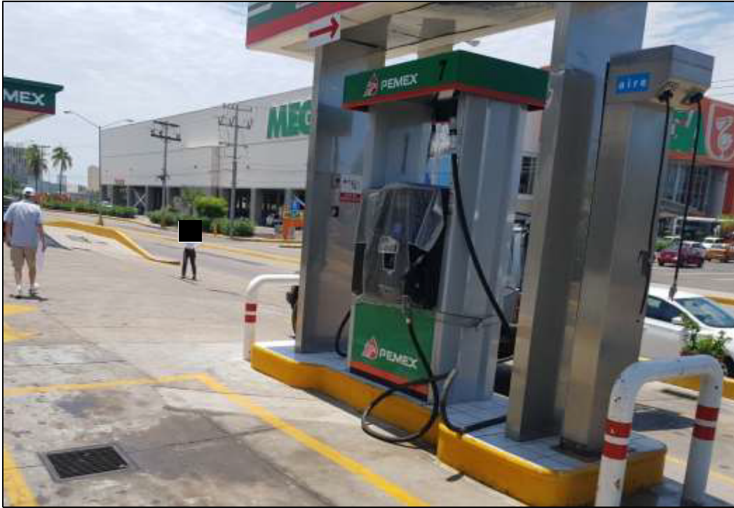
Fotografía 5. Zona de despacho de Diesel.
