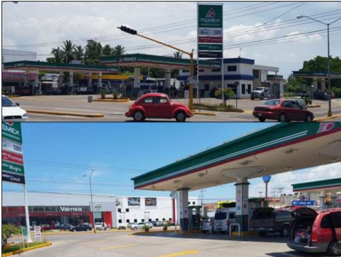
Fotografía 11. Visibilidad de la Estación de Servicio No. 3203.
