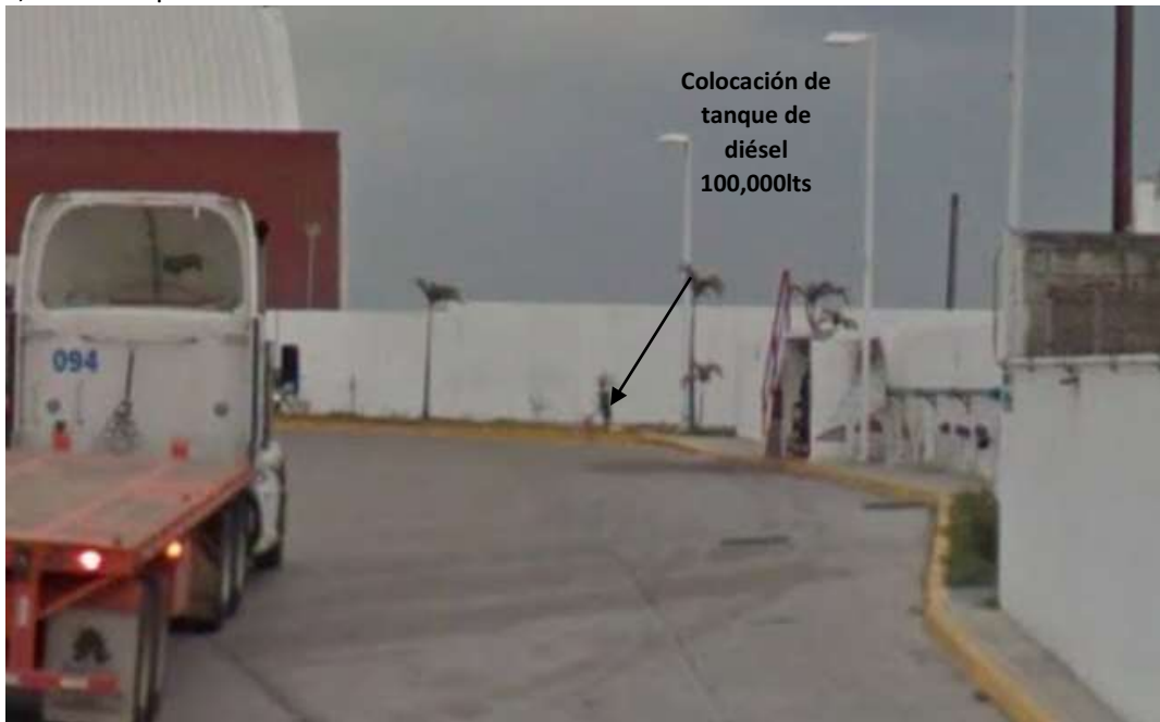
Fotografía 2. Vista de la ubicación donde se colocará el tanque de diésel de 100,000 litros.
