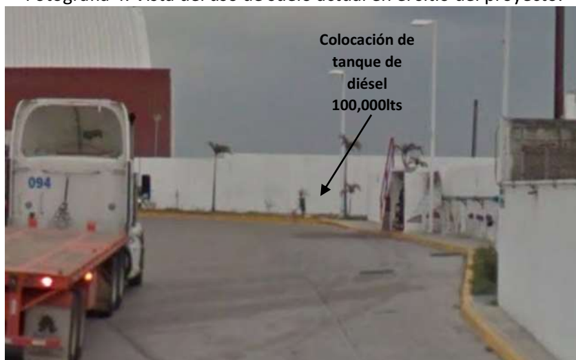
Fotografía 5. Lugar donde se instalara el tanque
