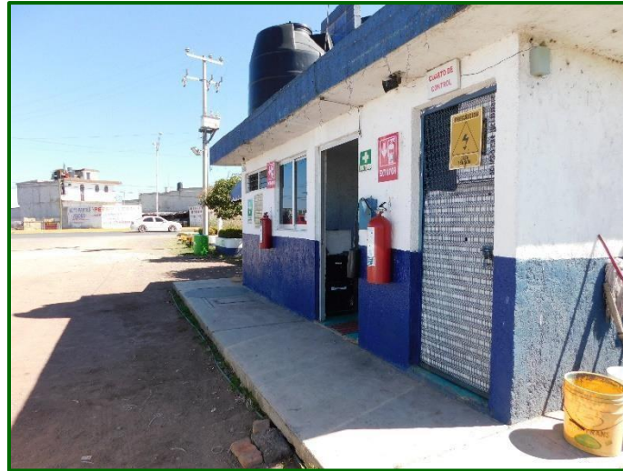
Imagen 4. Oficinas y cuarto de control
