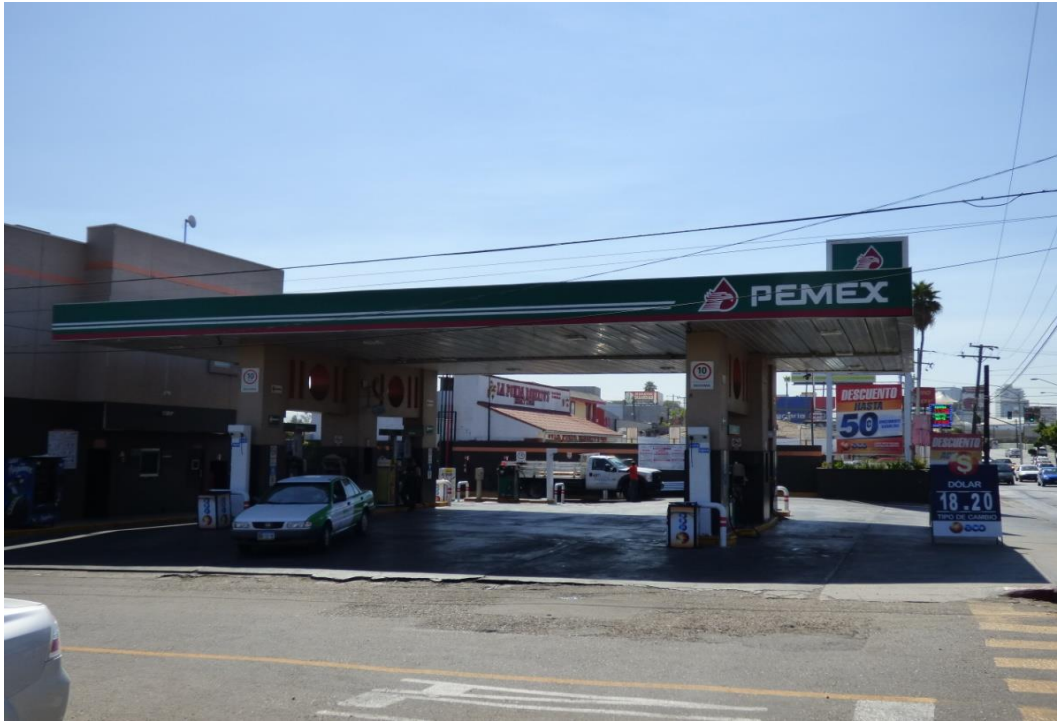
Fotografía 1. Vista general de la estación de Autoservicio Tijuana S.A. de C.V.
