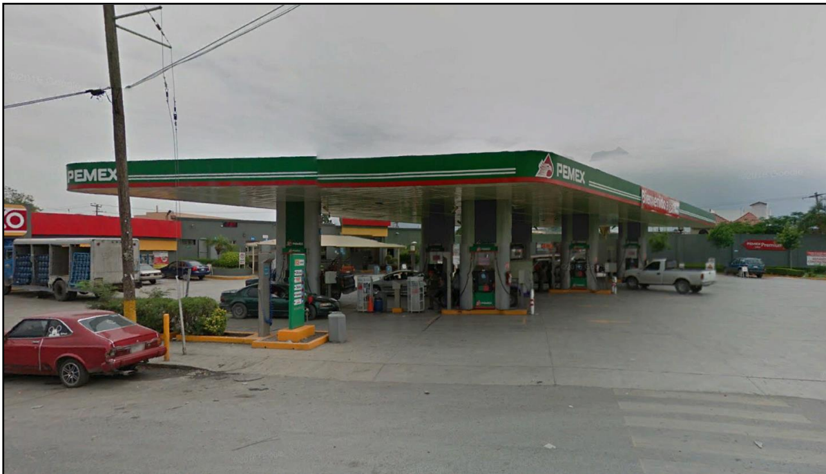
Imagen 1. Vista de la estación de servicio.
