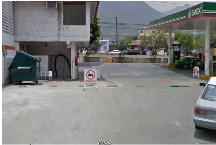
Figura 5. Área de tanques de almacenamiento de la estación de servicio.
