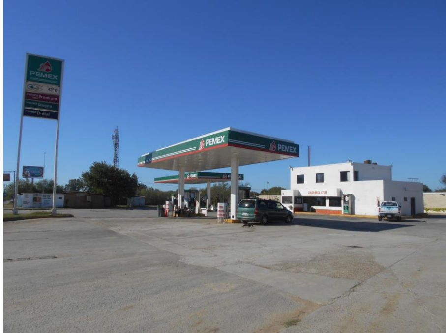
Figura 1. Vista frontal de la estación de servicio.
