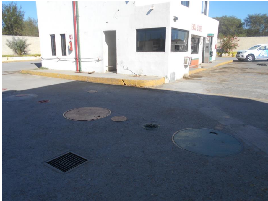
Figura 4. Área de tanques de almacenamiento de gasolina magna y gasolina premium.
