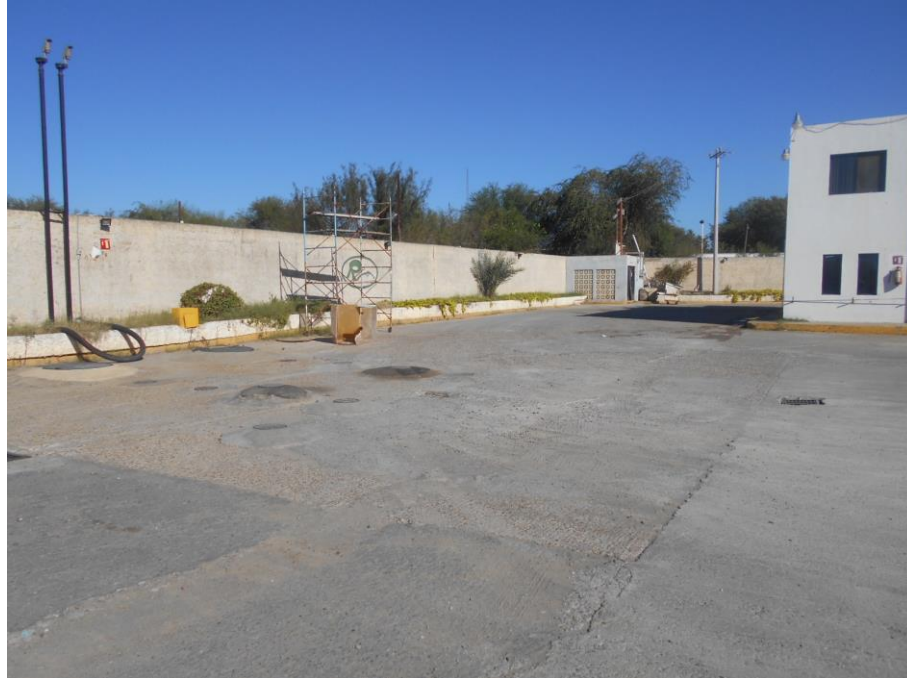
Figura 5. Área de tanques de almacenamiento de diésel.
