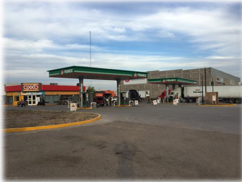
Frente de la gasolinera
