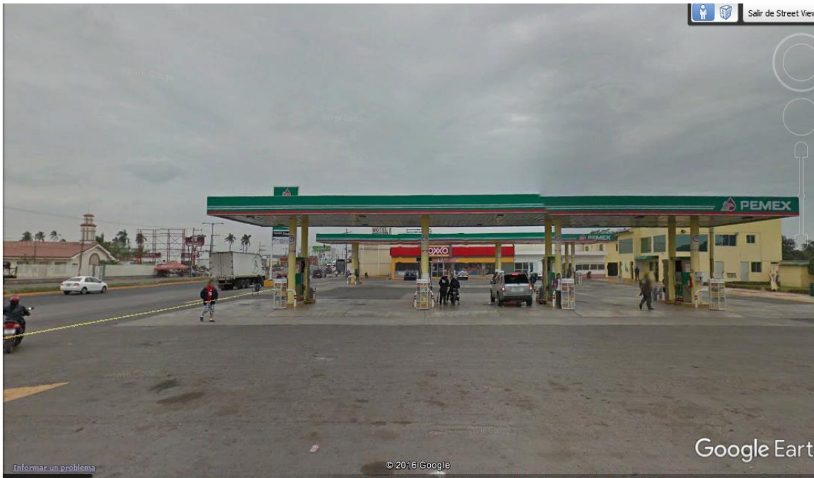
Imagen 5. Panorámica de la estación de servicio.
