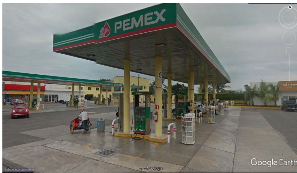
Imagen 4. Área de bombeo y venta de combustible.
