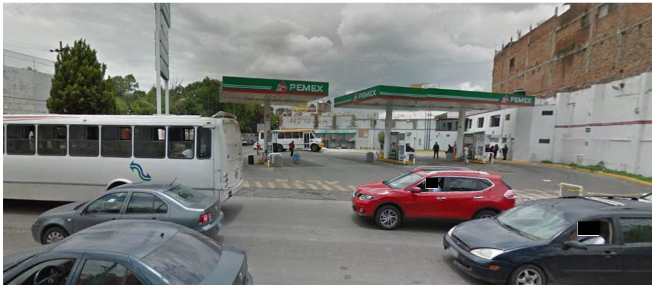
Vista de la Estación de Servicio 1532, ubicada en la R. Michel.
