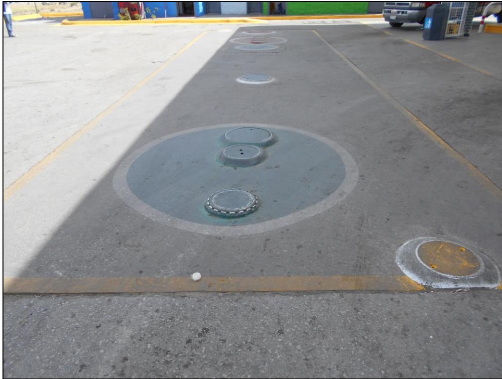
Figura 3. Área de tanques de almacenamiento.
