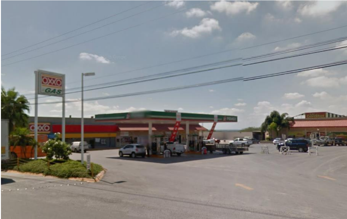
Figura 1. Vista frontal de la estación de servicio.
