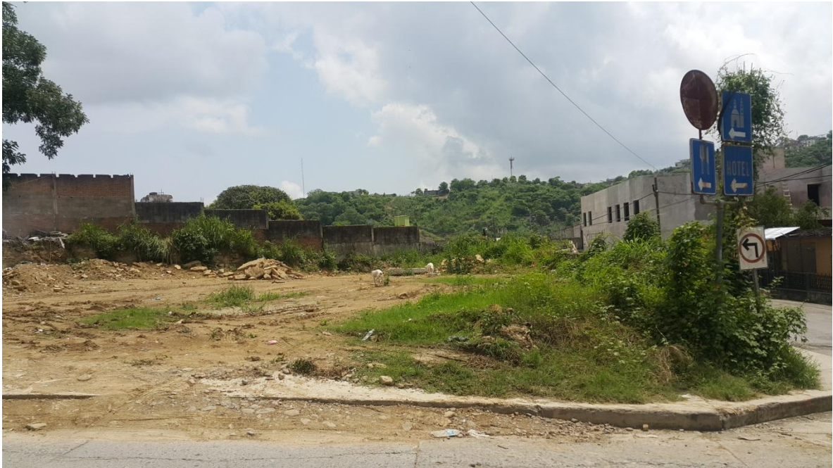
Foto 6. Vista general del predio
