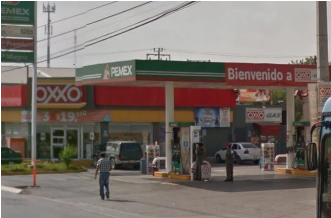
Figura 1. Vista de la estación de servicio en evaluación.
