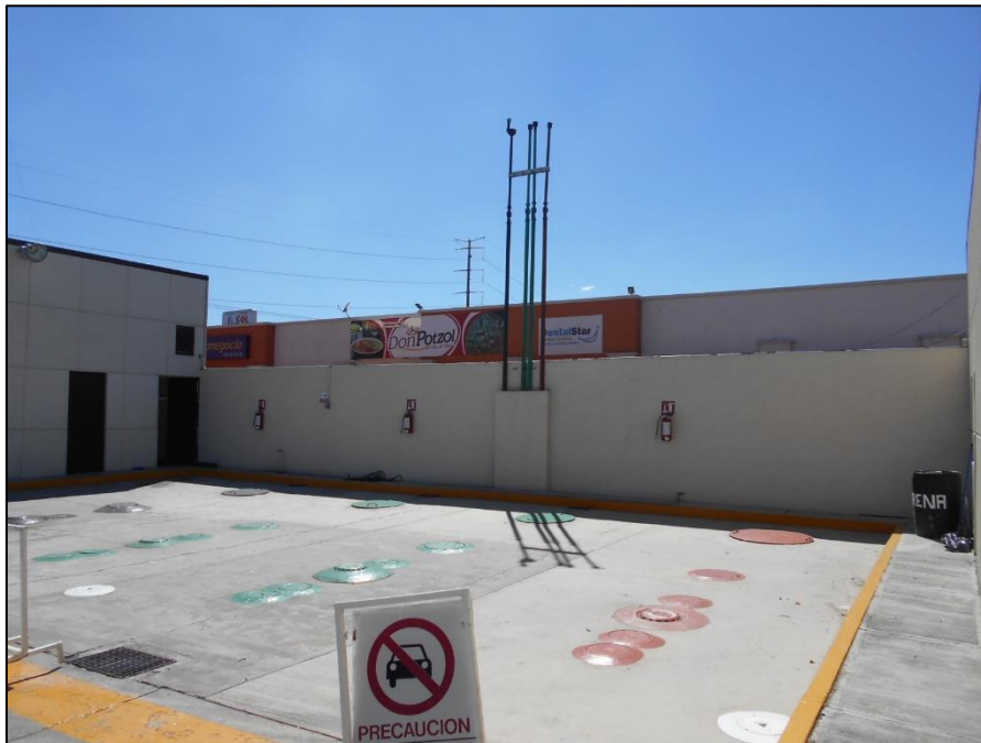
Imagen 4. Área de tanques de almacenamiento y venteos.
