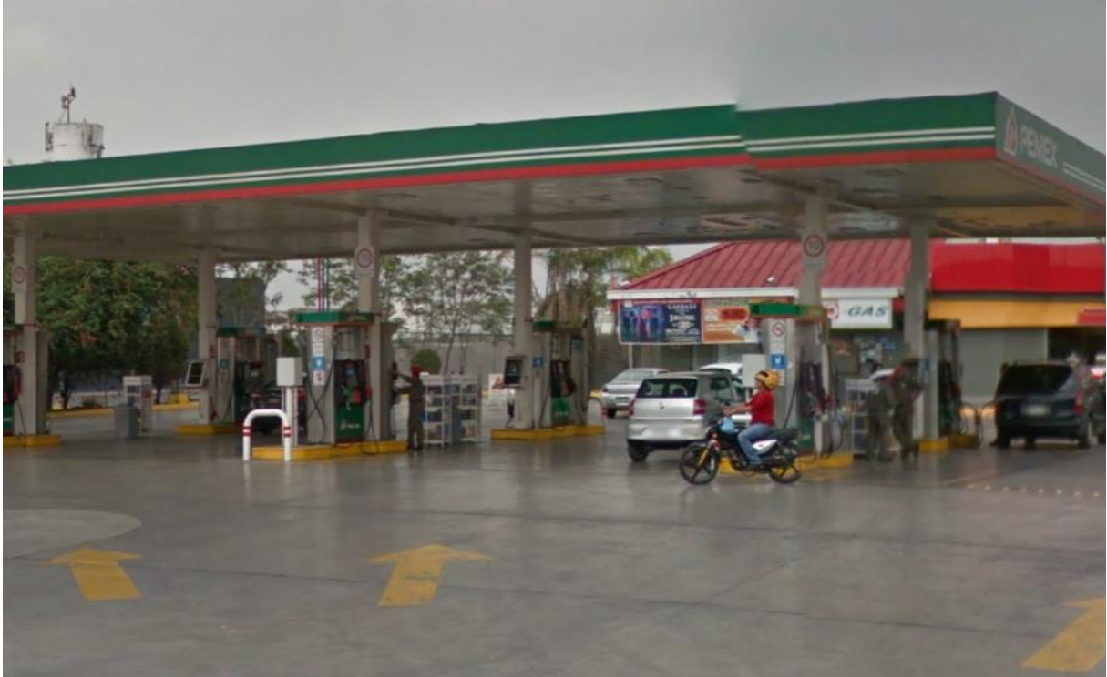
Figura 1. Vista frontal de la estación de servicio.
