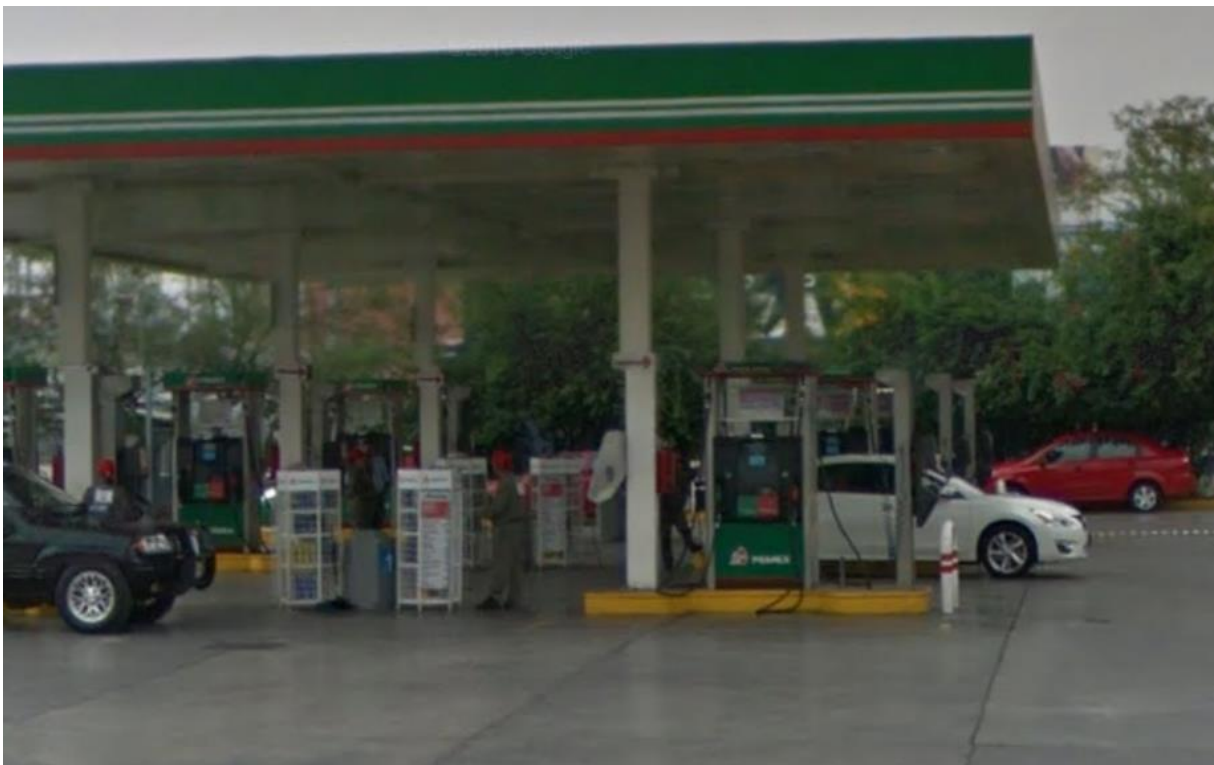
Figura 4. Dispensarios de la estación de servicio.
