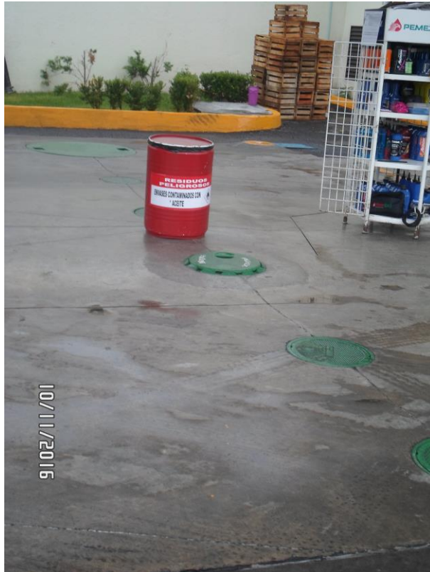
Figura 7. Almacenamiento de residuos peligrosos. A la izquierda se observa un contenedor específico en uso, a la derecha el cuarto de sucios, con piso impermeable y conexión al drenaje aceitoso.
