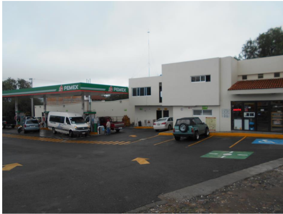
Figura 1. Vista frontal de la estación de servicio.
