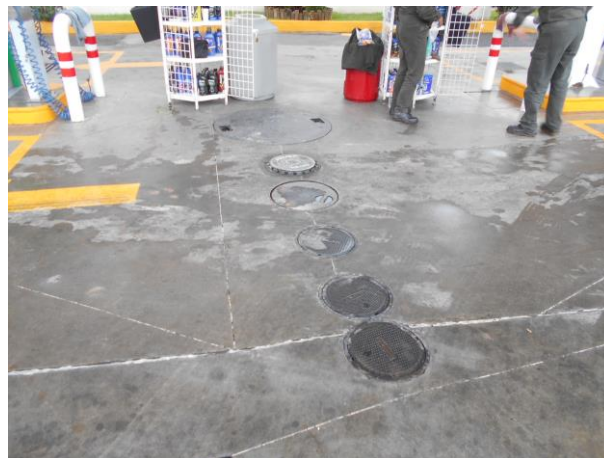
Figura 5. Áreas de tanques de almacenamiento, se aprecian en orden descendente las tomas del tanque de gasolina premium (40,000.00 litros), gasolina magna (80,000.00 litros) y diésel (40,000.00 litros).
