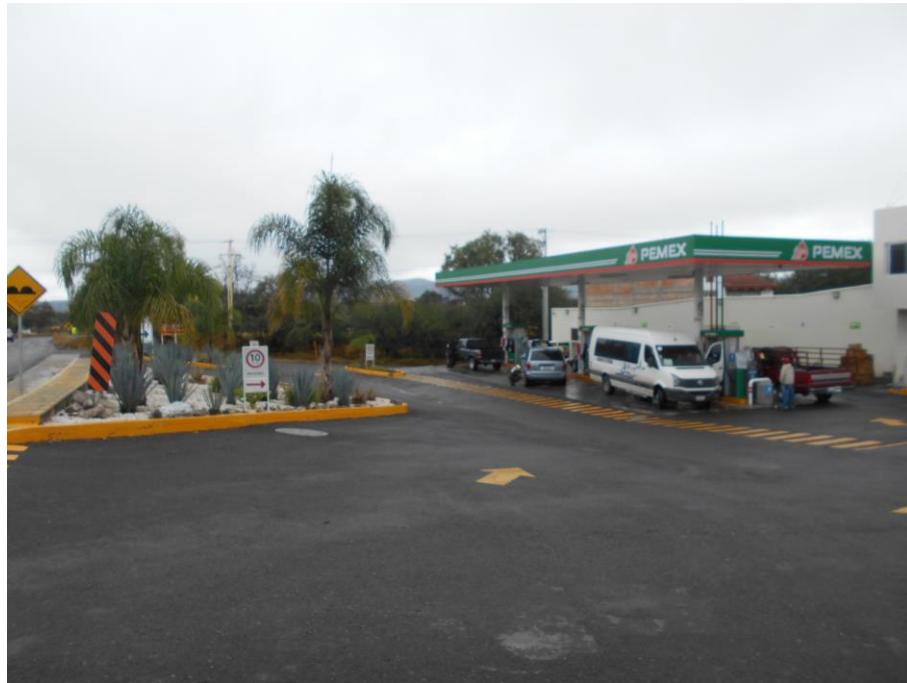
Figura 3. Acceso a la estación de servicio desde la carretera estatal 200.
