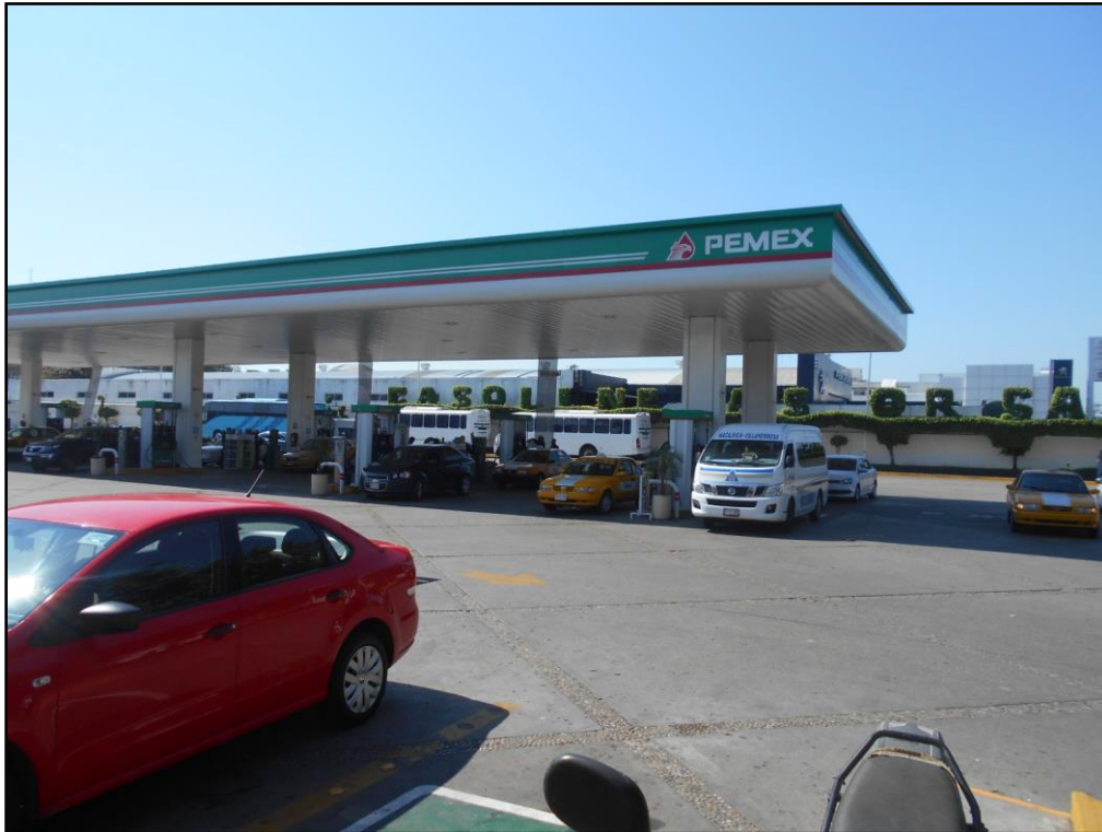
Imagen 3. Vista de la estación de servicio.
