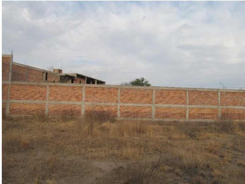
Construcción a demoler
