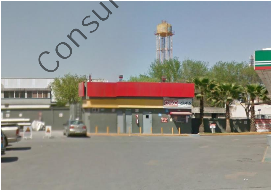
Figura 4. Área de oficinas y área verde de la estación de servicio.
