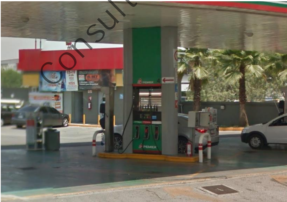
Figura 2. Dispensario de la estación de servicio.
