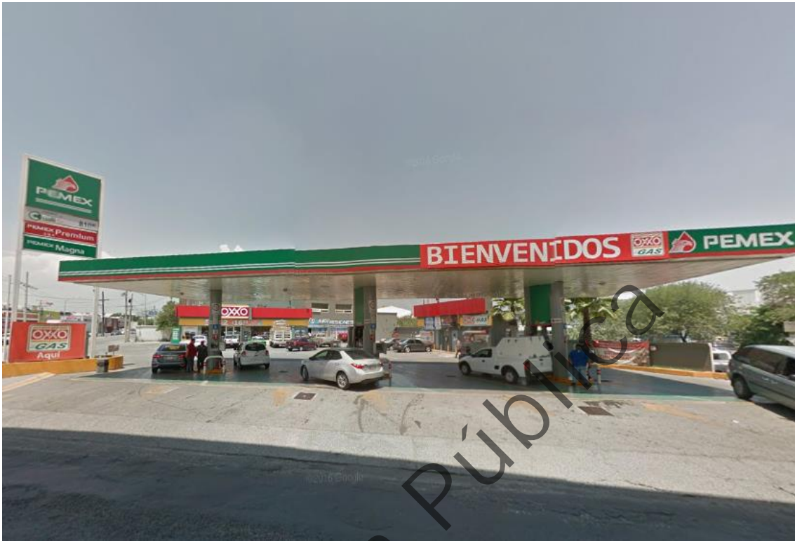
Figura 1. Vista frontal de la estación de servicio.
