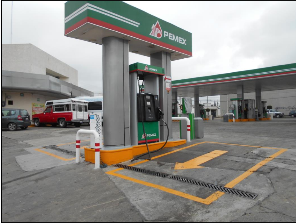
Imagen 3. Rejillas para las trampas de aceites.
