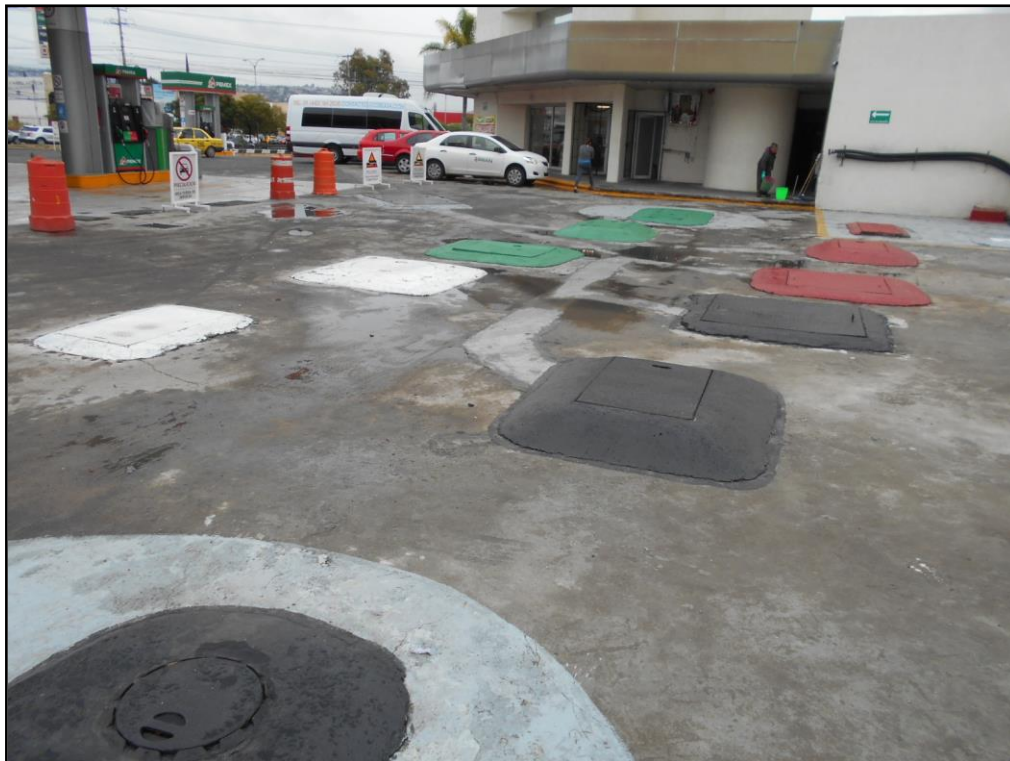
Imagen 2. Área de recarga de tanques de la estación de servicio.
