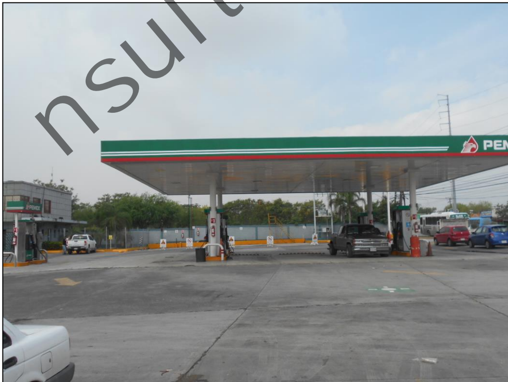
Imagen 6. Vista de la estación de servicio.
