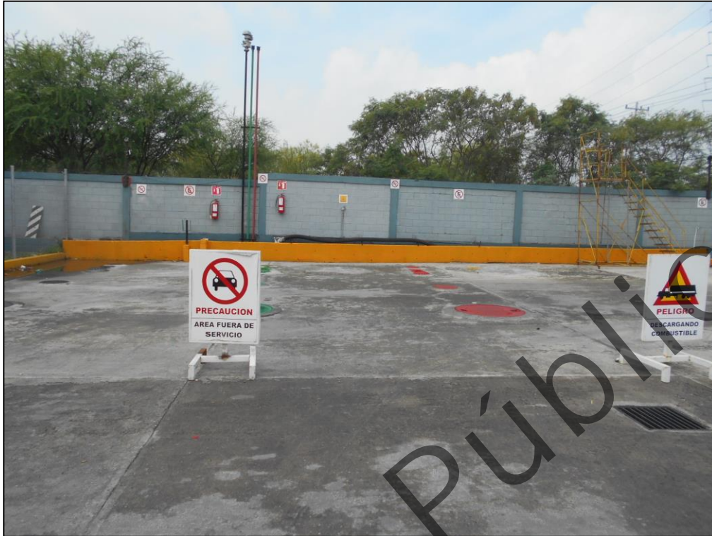
Imagen 1. Área de carga a los tanques de almacenamiento.
