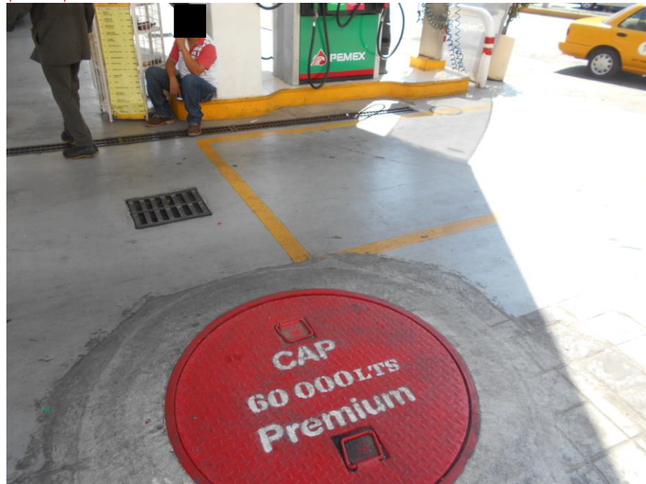
Figura 4. Tanques de almacenamiento de la estación de servicio.
