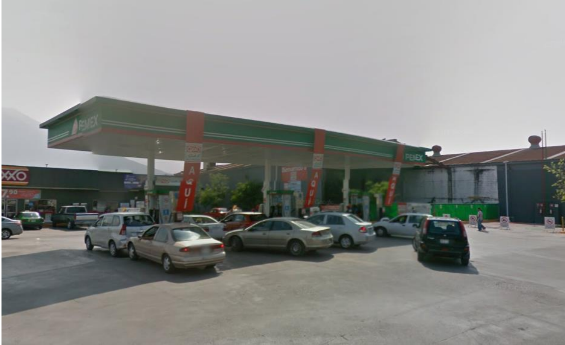
Figura 1. Vista frontal de la estación de servicio.
