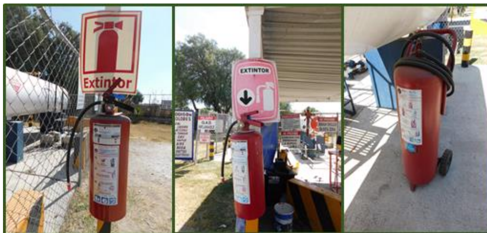
Imagen 6 Evidencia de ubicacion de extintores
