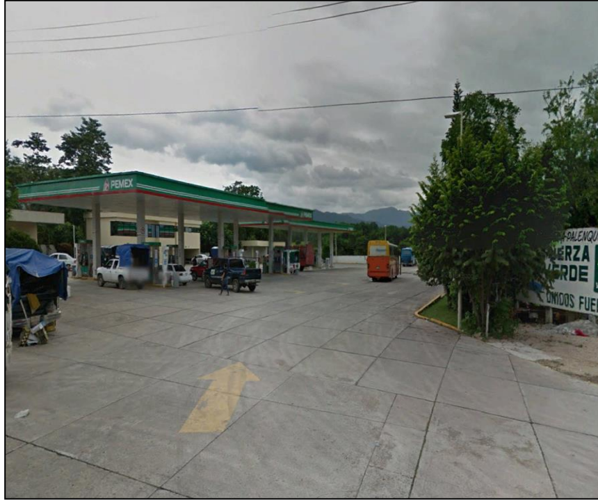
Imagen 5. Vista de la estación de servicio.
