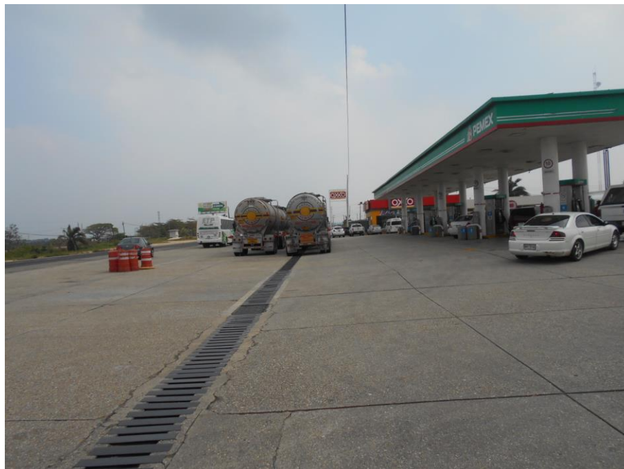
Figura 2. Rejillas de drenaje pluvial de la estación de servicio.
