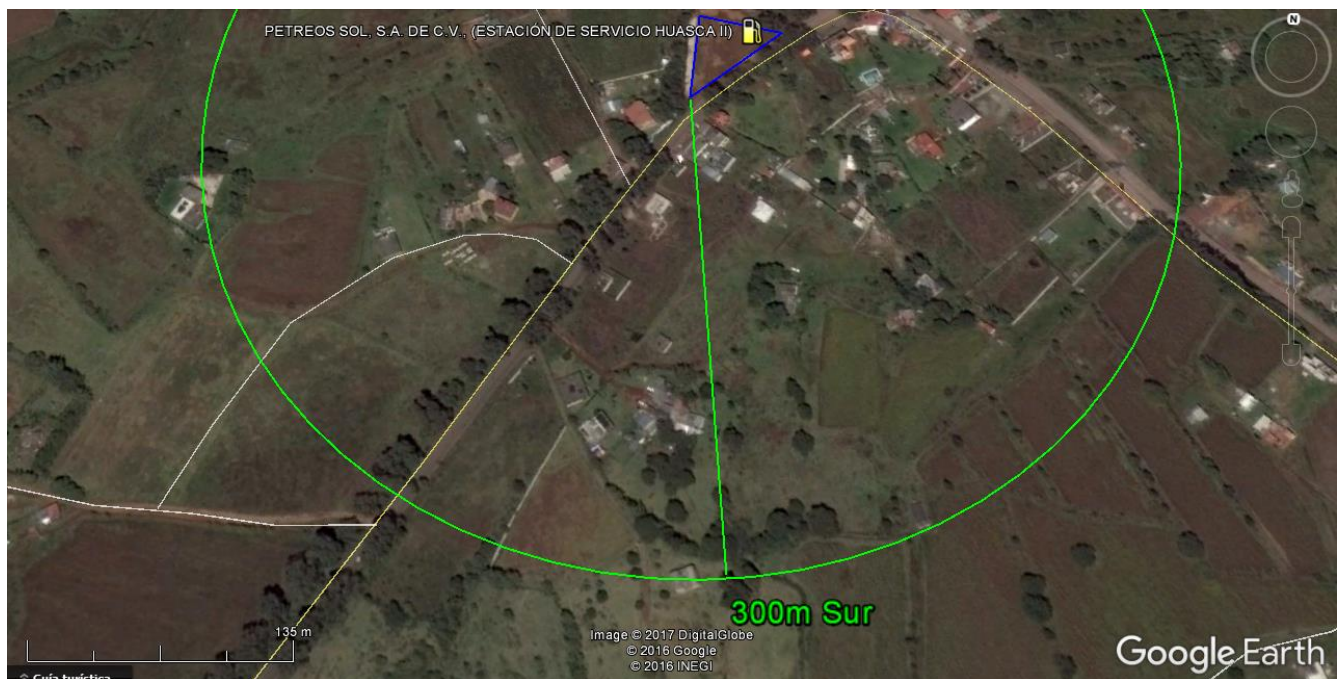
Figura 14. Infraestructura existente y colindancias a 300 m al SUR, de la "Estación de Servicio Huasca II".
