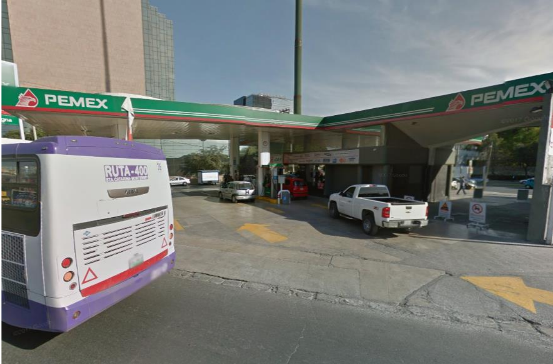
Figura 1. Estación de servicio vista de noroeste a sureste.
