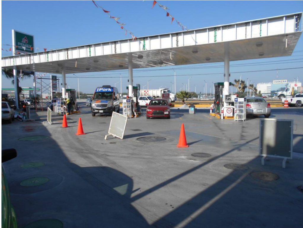
Figura 1. Vista general de la estación de servicio.
