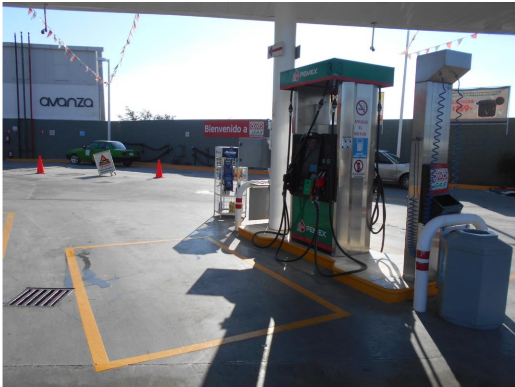
Figura 2. Área de despacho de gasolinas de la estación de servicio.
