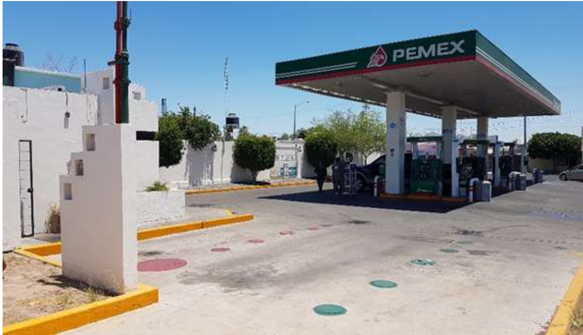
Área de tanques y al fondo módulo de despacho.
