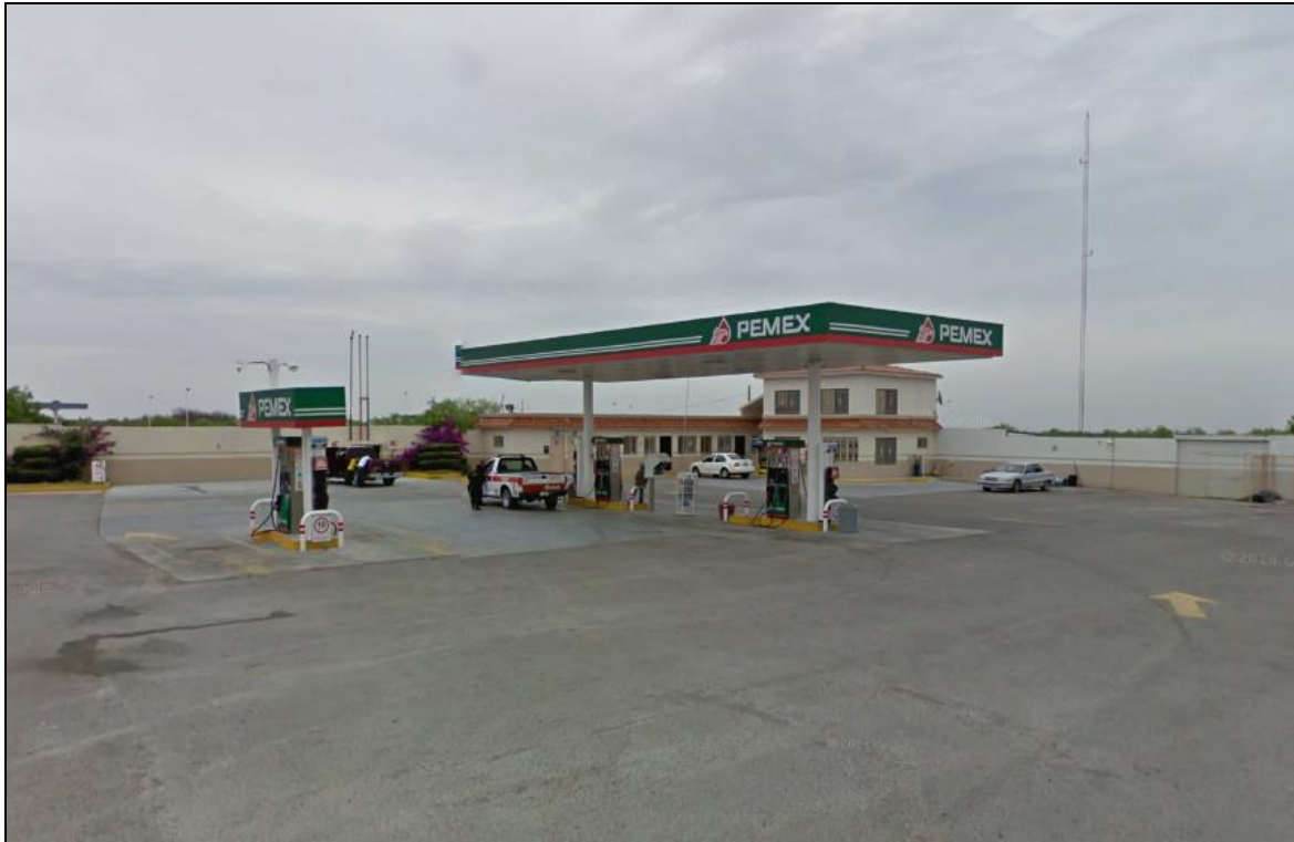
Figura 1. Vista general de las instalaciones de la estación de servicio.
