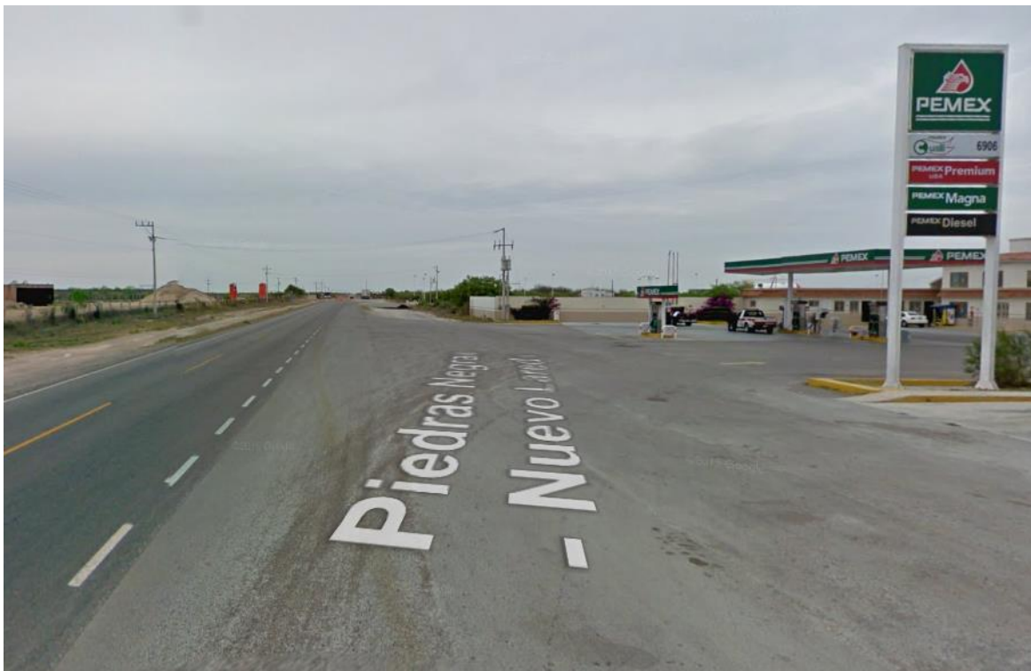
Figura 10. Colindancia oeste Carretera Nacional No. 2.
