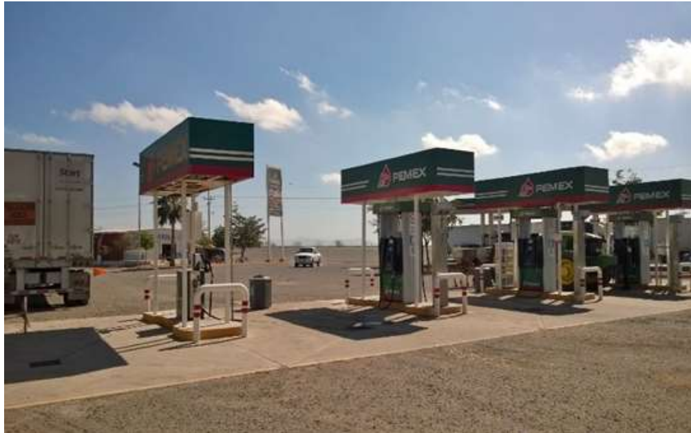
Módulos de diésel
