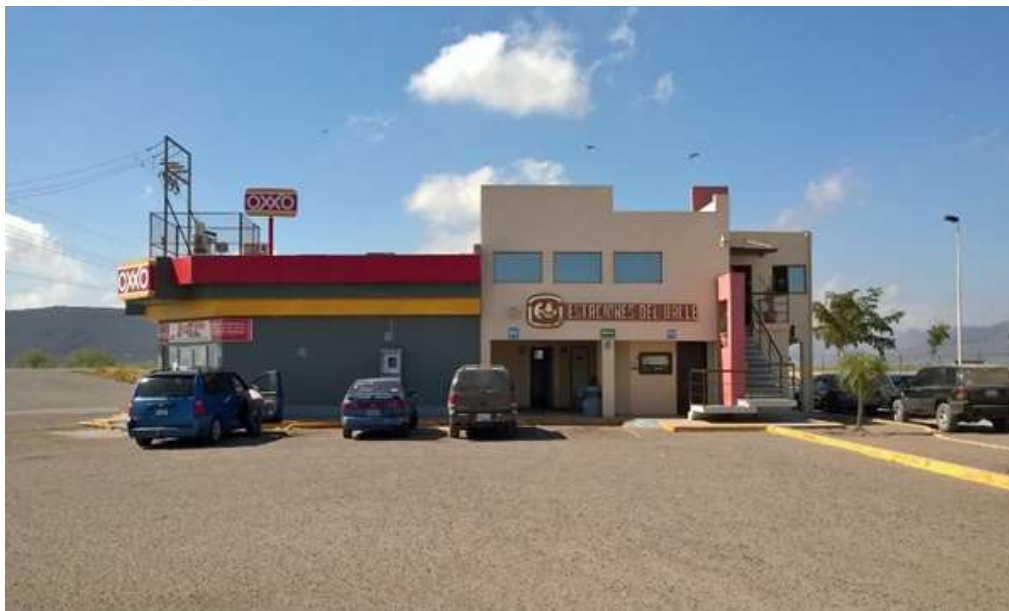
En esta imagen se muestra el edificio de oficina y tienda de conveniencia
