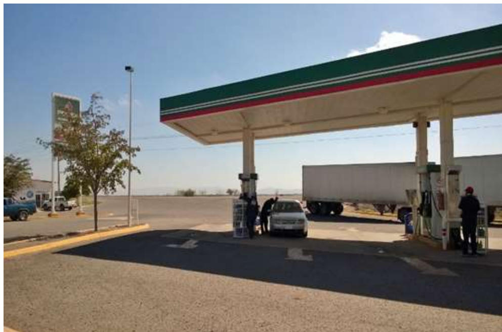
Módulo de despacho de gasolina en funcionamiento.
