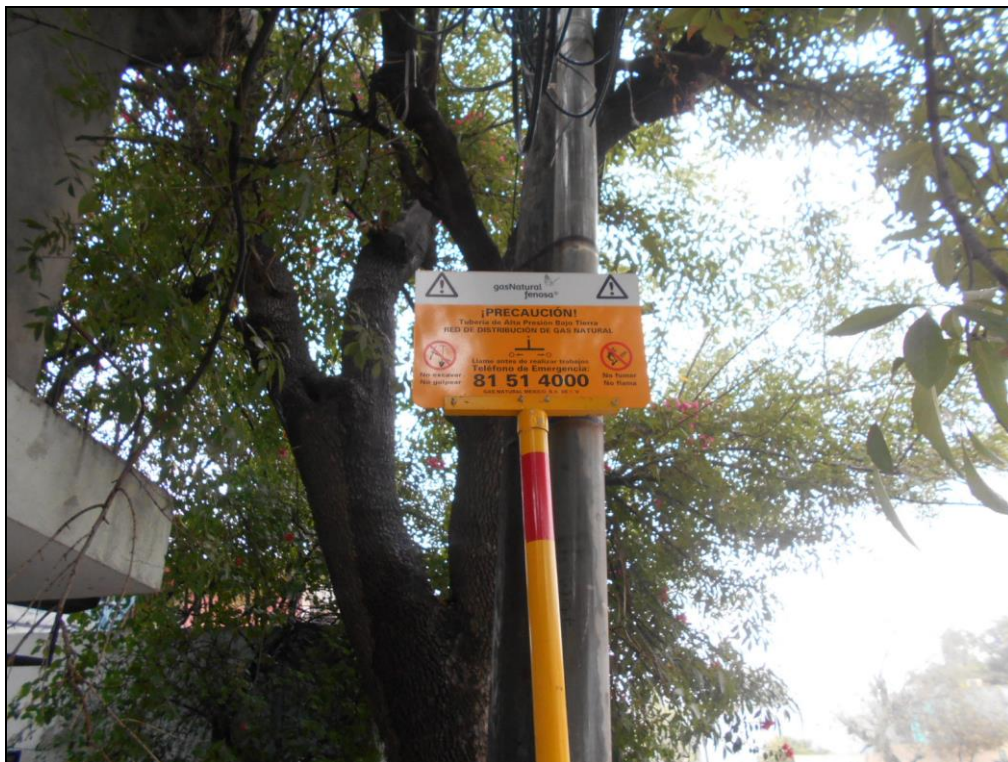
Figura 8. Línea de gas natural colindante a la estación de servicio.
