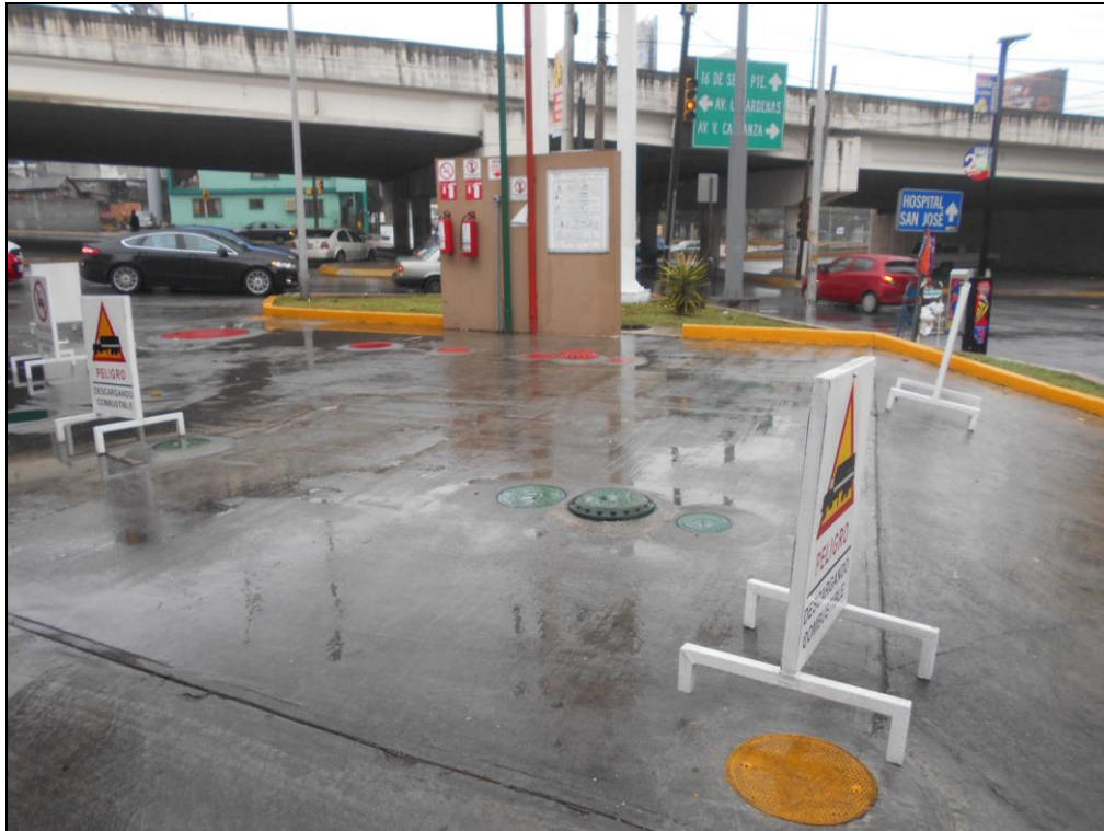
Figura 3. Área de tanques de almacenamiento.
