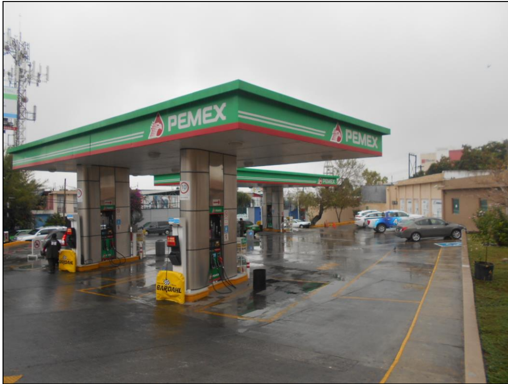
Figura 1. Vista lateral de las instalaciones de la estación de servicio.
